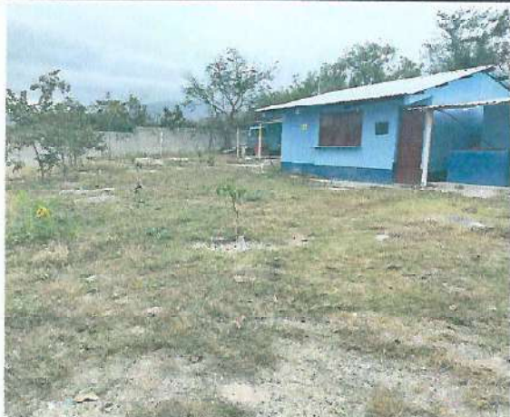
Foto1: Mejoramiento con Estructura tipo pórtico e instalación de lámina troquelada calibre 26 en salón de reuniones y mejoramiento de piso
