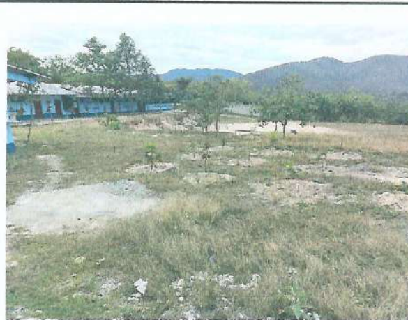
Foto 2: Mejoramiento con Estructura tipo pórtico e instalación de lámina troquelada calibre 26 en salón de reuniones y mejoramiento de piso
